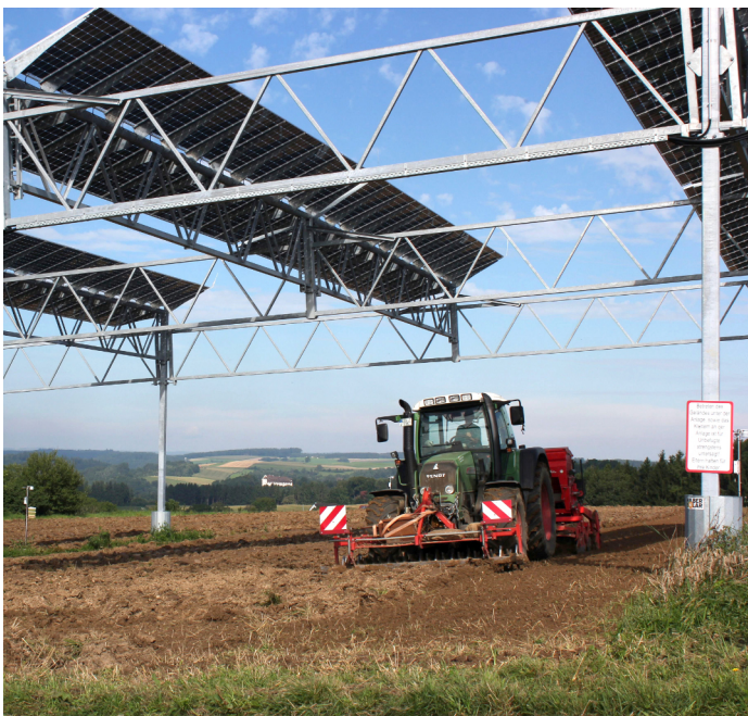
Agri-PV-Pilotanlage des Fraunhofer ISE in Hegelbach im Allgäu. Die Solarmodule sind so hoch angebracht, dass der Traktor für die Aussaat unten durchfahren kann. Foto: Fraunhofer ISE
