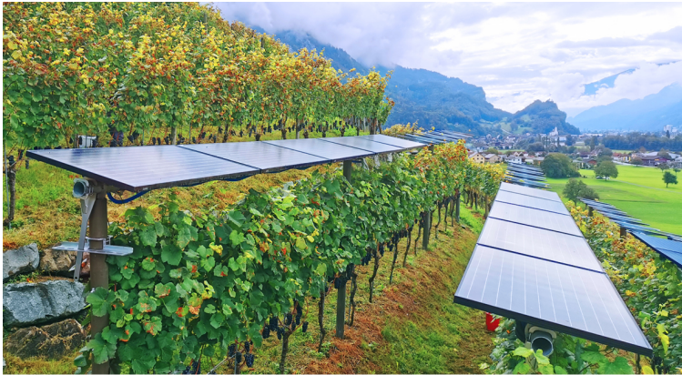
Oben: Agri-PV wird in der Schweiz erst in Ansätzen praktiziert: Bild einer privat initiierten Anlage über einem Rebberg in Walenstadt. Die Pflanzen unter den Solarmodulen sind weniger stark von Blattkrankheiten befallen. Da die PV-Module genügend hoch über den Pflanzen angebracht sind, hat die Stromproduktion in diesem Fall keine Ertragseinbussen zur Folge. Foto: Prof. Peter Schumacher/ZHAW
